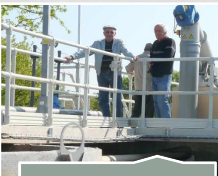
Journée portes ouvertes à la nouvelle station d'épuration
